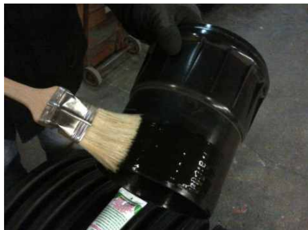
Смазване външната част на специалния фитинг
