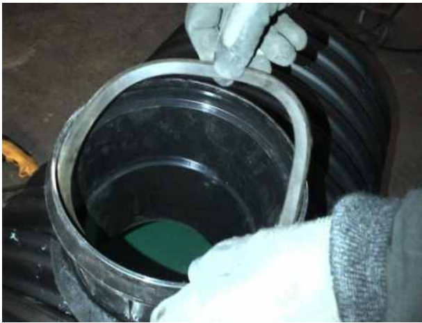
Само за PVC тръби: сложете PVC EN 1401 уплътнителя в сечението на фитинга
