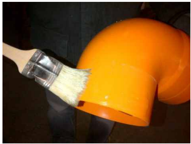
Смазване на фитинга преди свързване
