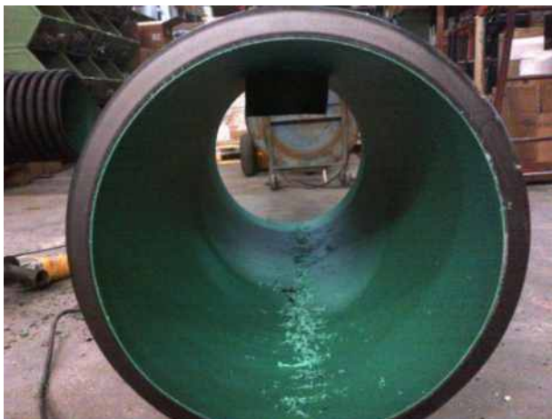
Отрязване на уплътнителя, в случай че е по-дълъг от дебелината на стената на основната тръба
