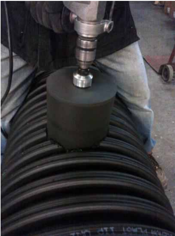
Пробиване на основната тръба
