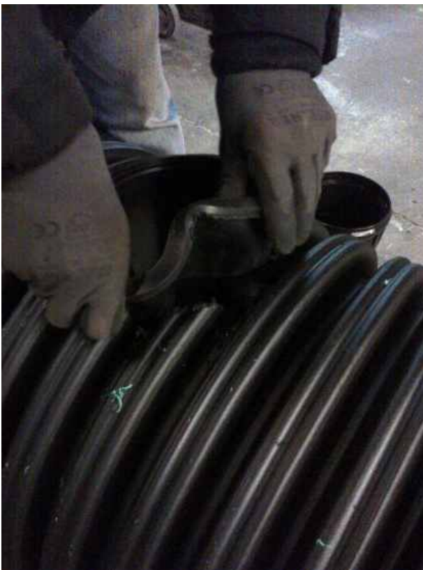
Позициониране на уплътнителя в отвора
