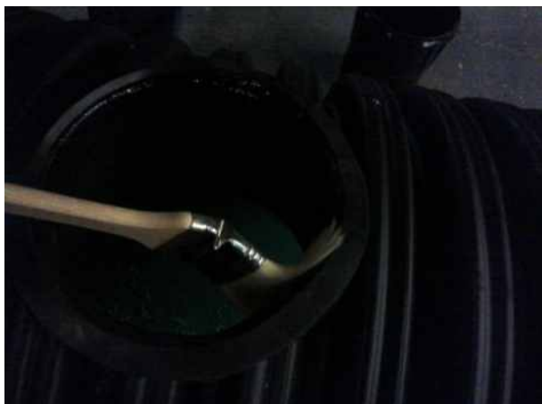
Смазване вътрешната част на уплътнителя
